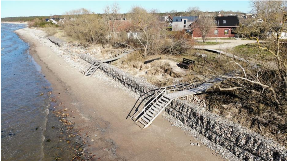
4.5. attēls: Pasīvās tradicionālas preterozijas būves – gabioni un laukakmeņu bankete Pāvilostā.
