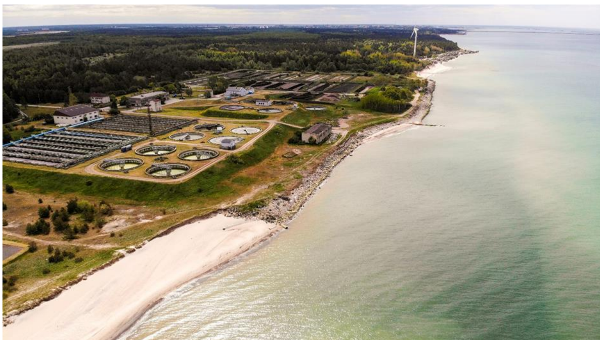
8. attēls. Tradicionālās pasīvā tipa preterozijas būves (gabioni un būvgružu-laukakmeņu bankete) pie Liepājas NAI. Būves piekājē pilnībā erodēta pludmale.
