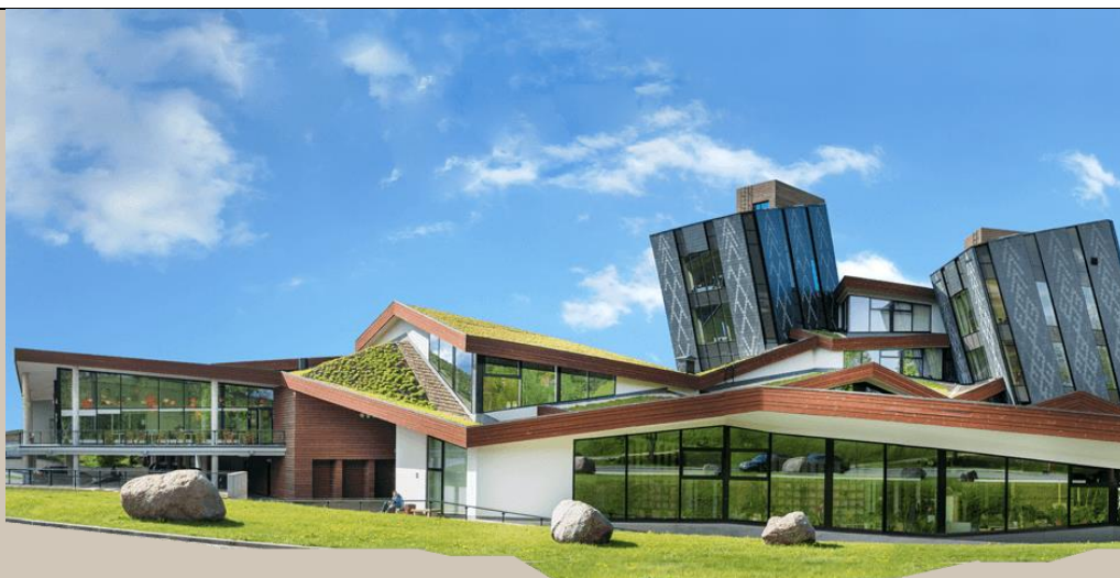
Attēls nr. 12 Austrumlatvijas radošo pakalpojumu centra „Zeimuls” ēkas zaļā jumta risinājumi 73
